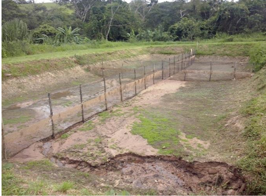
Foto 01. Preparación de los estanques.
