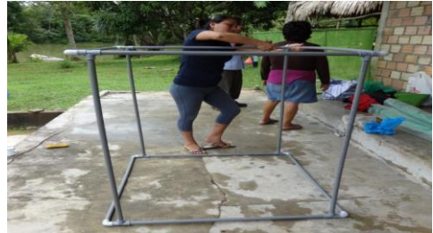
Foto 02: Armado de las jaulas.
