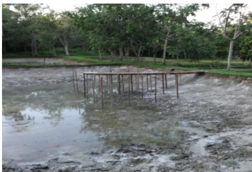
Foto 05: construcción de la base.
