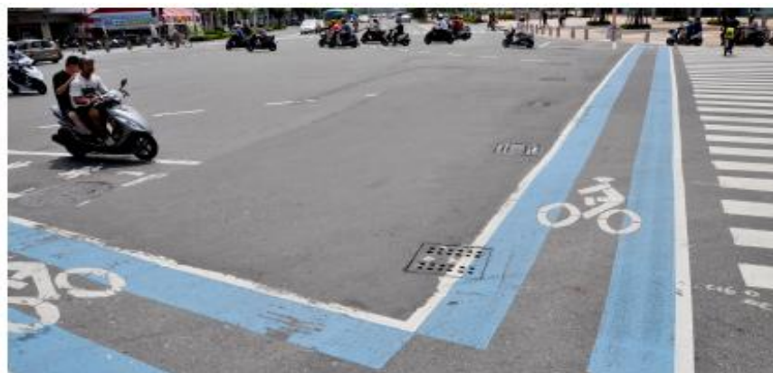
Imagen N° 11, Demarcación intersección cruce de ciclistas
