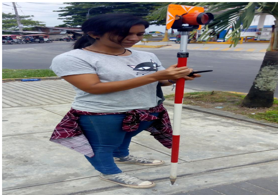
Foto N°04: Realizando el trabajo de campo con el prisma y la estación total.
