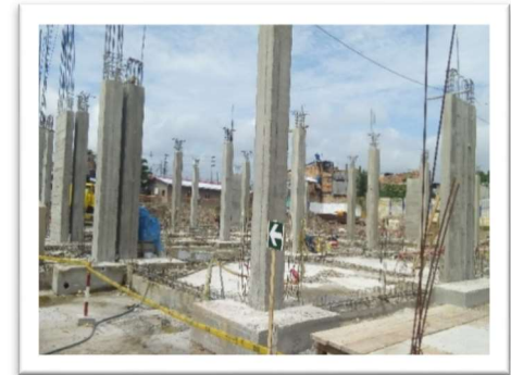
Construcción de la obra
