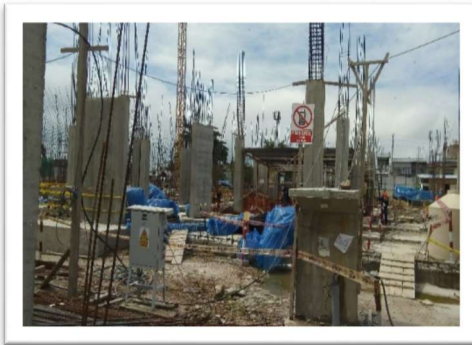
Vista de Obra por dentro
