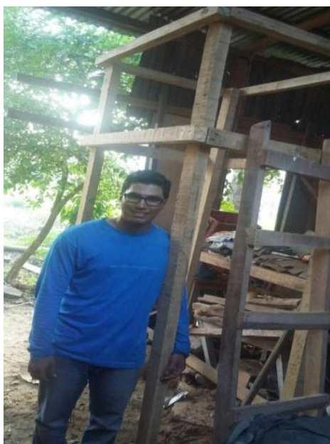
Foto 19: galpón para el tratamiento N° 03 a dos metros de altura.
