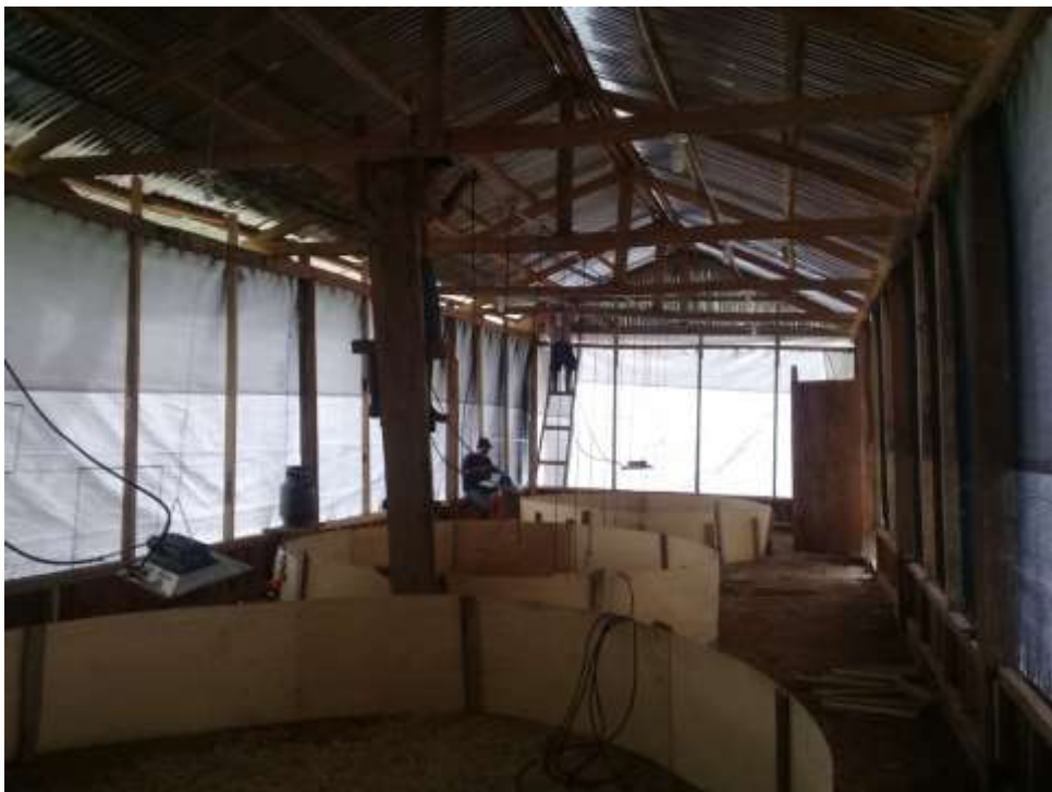
Foto 2. Construcción de las circulinas para la recepción de los pollos.
