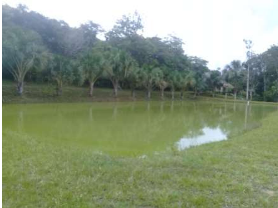
Foto 2. Futura área destinada para la construcción de estanques.
