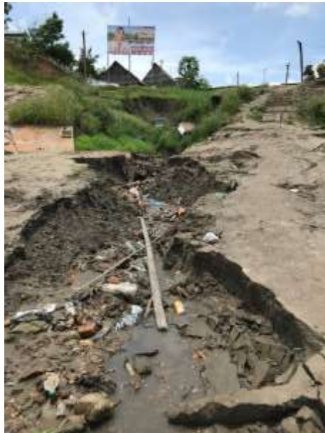
Foto N°09: Lugar por dónde drenan las Aguas Residuales Domésticas de la ciudad de Tamshiyacu
