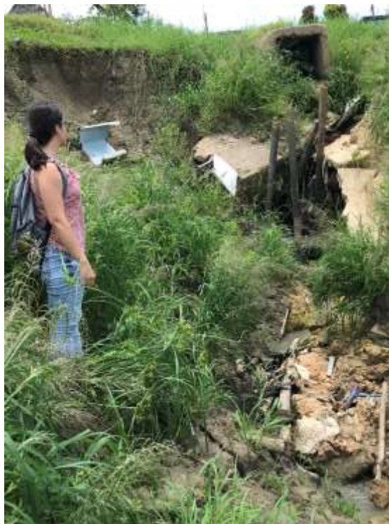
Foto N°12: Observación del desagüe
