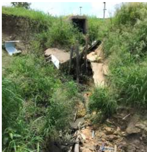
Foto N°10: Desagüe de la ciudad
