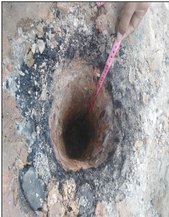
Figura 18. Hoyo para la colocación de las humishas
