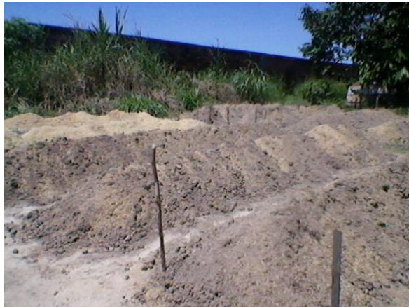
FOTO 02. PREPARACION DEL TERRENO
