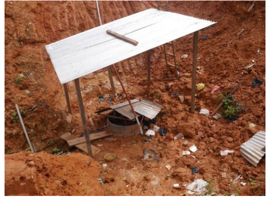
3. Pozo de Almacenamiento -Lixiviado
