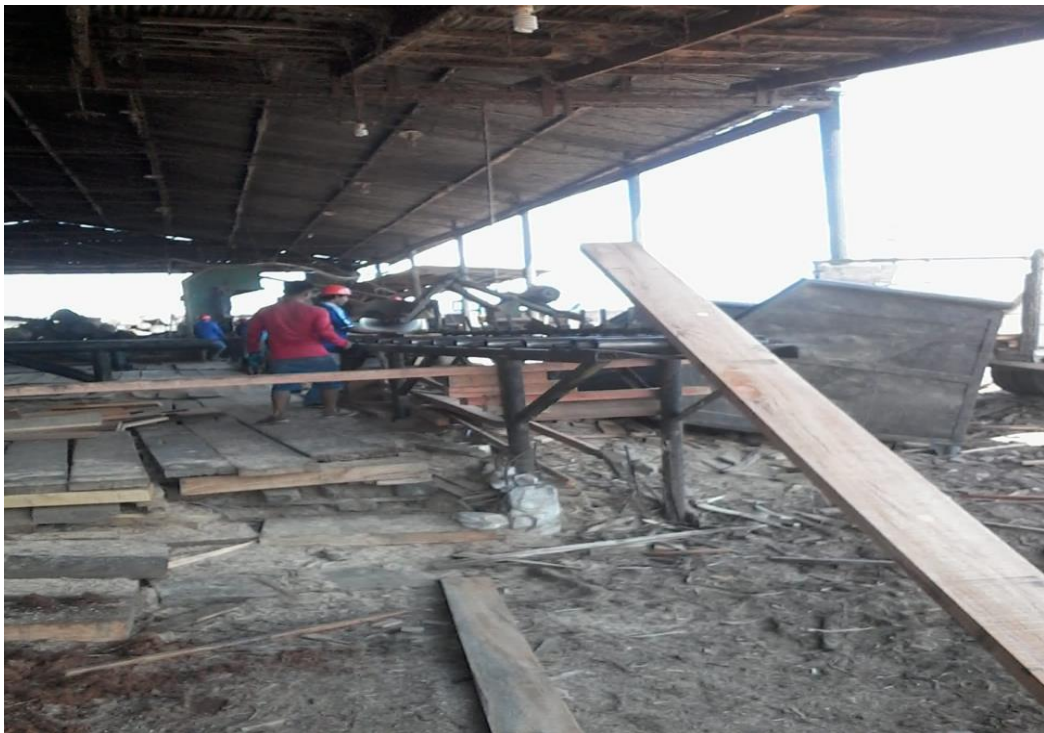
Foto 2. Cepilladora. No uso total de EPP.
