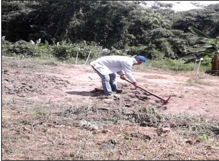
Foto 01: Preparación del terreno
