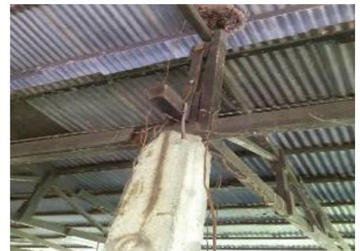
Foto 12: Fierros expuestos al cableado eléctrico
