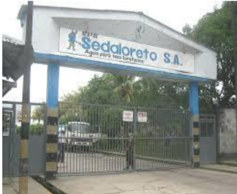
Imagen 1. Planta de tratamiento de agua potable Sedaloreto.
