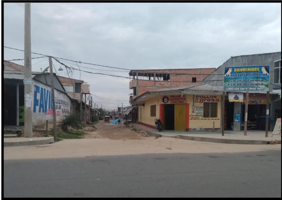
Ilustración 1. "Asentamiento Humano "Santa Rosa de Lima"
