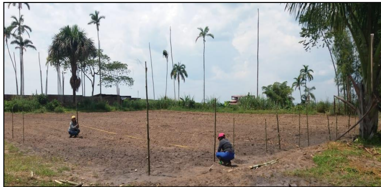
FOTO N° 1 PARCELACION DEL TERRENO
