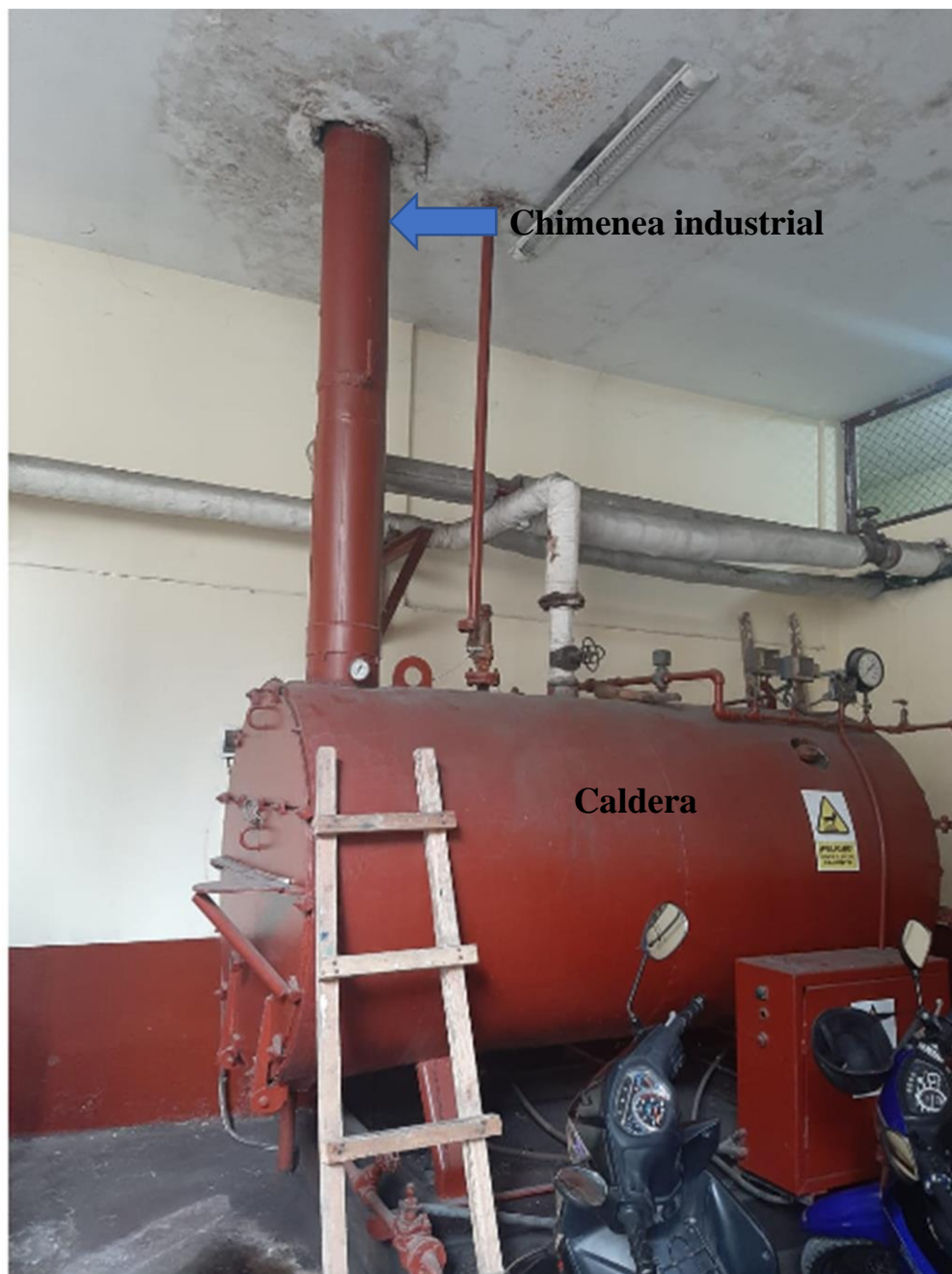
Anexo 5. Vista de la chimenea industrial de la Planta Piloto FIQ-UNAP.
