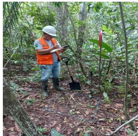
Foto 12. Inicio de apertura de calicata
