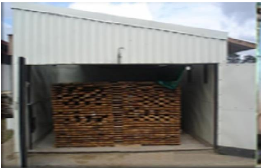
Figura 09: Cámara de secado de madera cumala de la empresa
