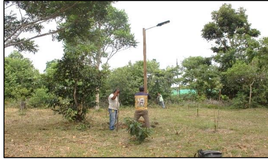
Foto 2. Instalación de luces
